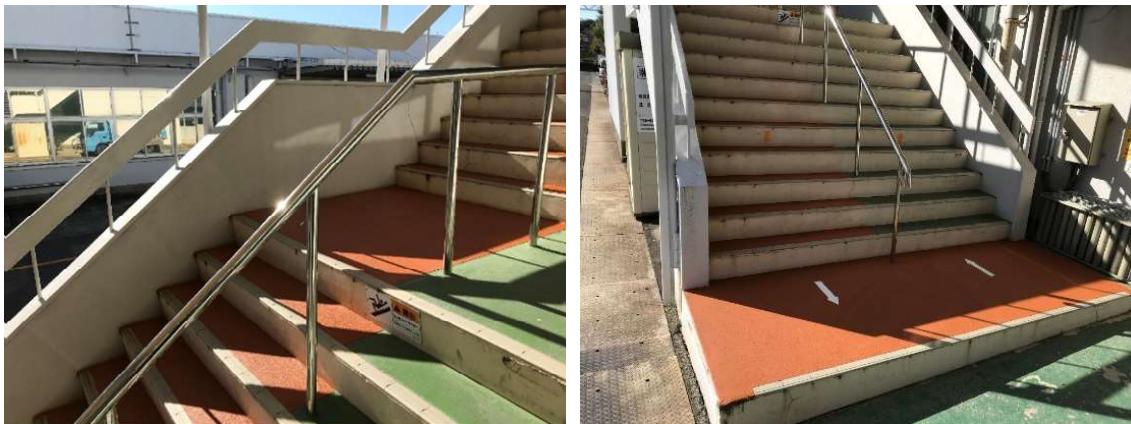
■ 楽器メーカーY社（静岡県）：社員食堂棟のコンクリート塗装仕上げの階段に施工 ※ 施工後、矢印などを白の塗料で塗工
