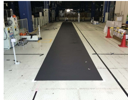
■ T自動車（愛知県）：製造ラインの作業者の歩行する縞鋼板のデッキに施工
