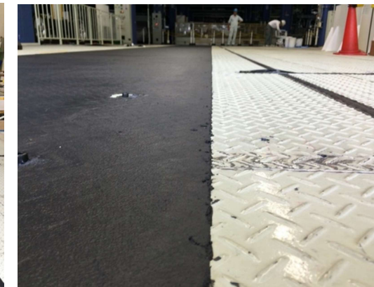
■ T自動車（愛知県）：製造ラインの作業者の歩行する縞鋼板のデッキに施工
