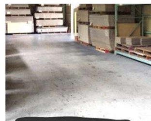
工場内コンクリート床
