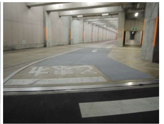
■ エコパスタジアム（静岡県）： 駐車場の通路の曲がり部分のコンクリート仕上げの面に部分的に施工
