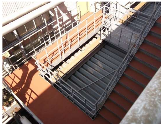
■ H自動車（東京都）： 工場内の縞鋼板の階段・通路デッキに施工
