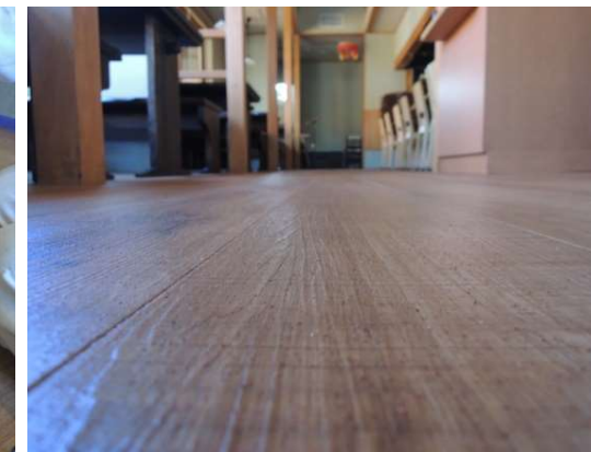
■ 飲食店舗（静岡県）： 木目調樹脂製長尺シートの床に施工 ※ 油で滑り易くなりがちな床の滑りを改善
