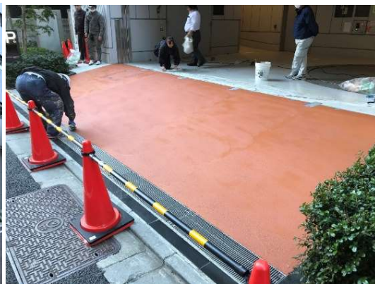
■ 立体駐車場（都内）： 駐車場前の塗装仕上げのコンクリートのスロープに施工
