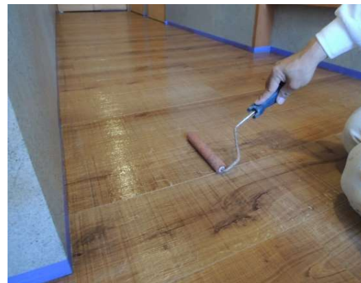
■ 飲食店舗（静岡県）： 木目調樹脂製長尺シートの床に施工 ※ 油で滑り易くなりがちな床の滑りを改善
